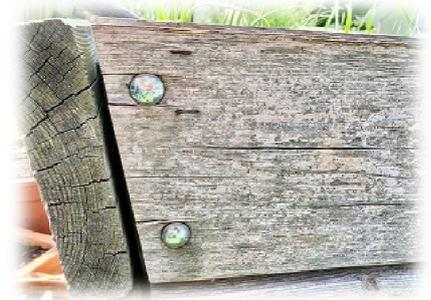
Der Untergrund **muss** sauber, trocken, staub und fett frei sein. Das Holz (wenn das Holz einige Jahre alt ist) abreiben mit einer Bürste bzw. Drahtbürste danach gründlich reinigen und alle Schleifpartikel entfernen (feuchtes Tuch und trocknen lassen)
