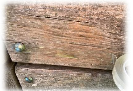
Das geklebte Nanoband (die Schutzfolie ist noch oben) mit den Fingern an das Holz sehr fest andrücken. Danach einige Stunden warten bis die Klebekraft sich auf dem Holz verfestigt. Danach nochmal mit einem harten breiten Gegenstand alle 1-2 cm fest an das Holz anpressen.
